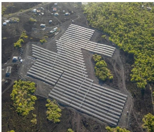
Centrale solaire de Foubouni
