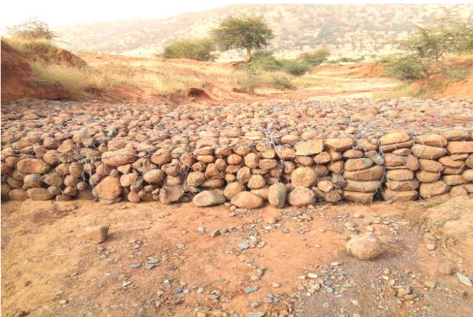
Travaux de réalisation des gabions
