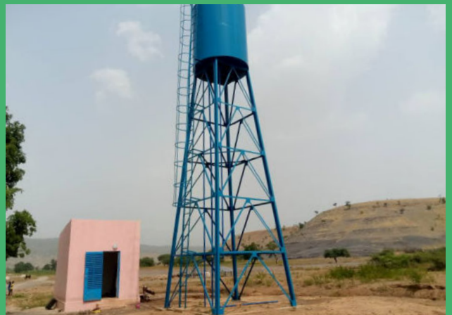
Réalisation du forage & du château d'eau (Octobre 2022)
