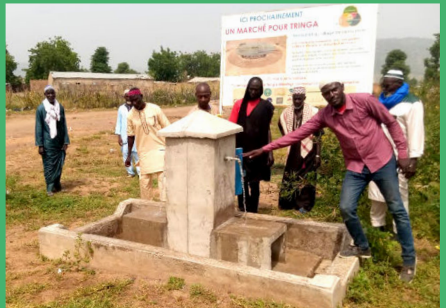
Récéption provisoire de l'adduction d'eau du marché (Octobre 2022)
